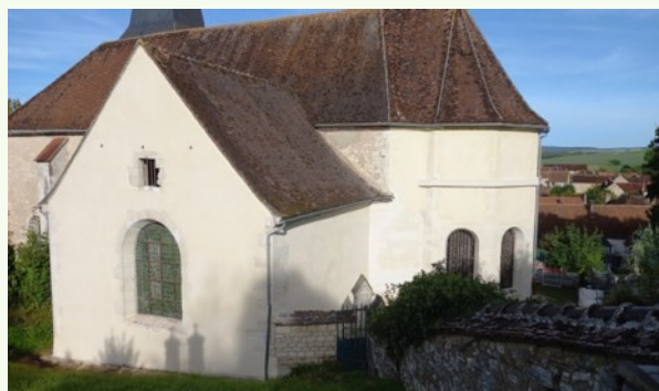
Restauration murs église Réalisée par la société Gebat
