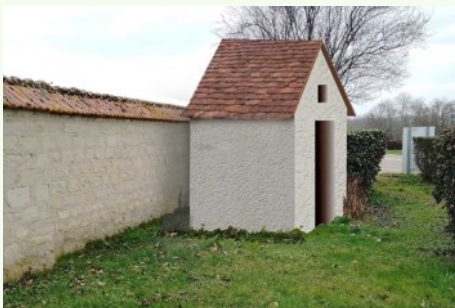
Abri du surpresseur du Ruet
